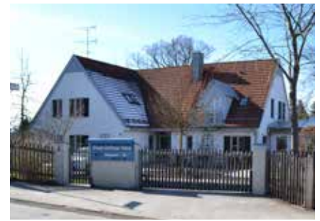
Das Urban-Dettmar-Haus in der Dorfstraße.
